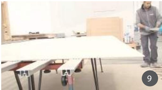
Специальными обрезными кусачками начинайте отламывать отрезанную часть с обоих концов плиты (10,11), следуя линии надреза (12).
