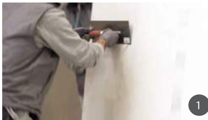
Сначала нанесите клей на заднюю сторону плиты зубчатым шпателем с зубьями 3 мм (1). Рекомендуется клей класса С2ТЕ S1, его нужно наносить в одном направлении (2).
