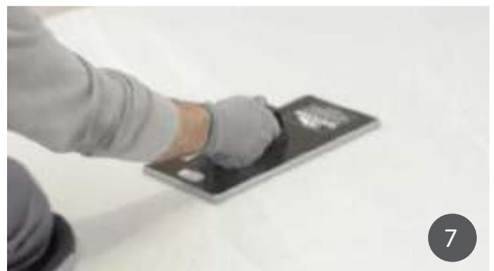
Завершите укладку с использованием соответствующего клея-герметика, оставляя швы не менее 3 мм с помощью специальных распорок (8).
