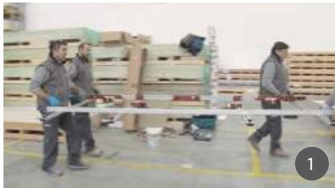
Для обеспечения идеального сцепления рекомендуется очистить влажной губкой поверхность плиты и присоски (2).
